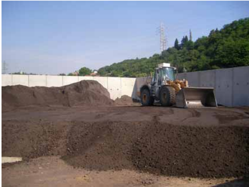
Figuur 17: Thermopile© in ex-situ configuratie, het vullen van het bassin.
